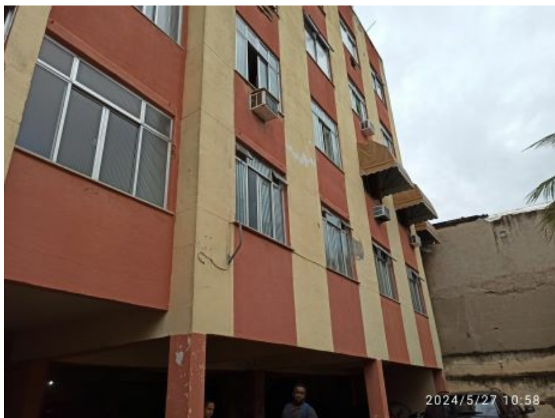
Figura 01: Fachada Edifício Rogério
