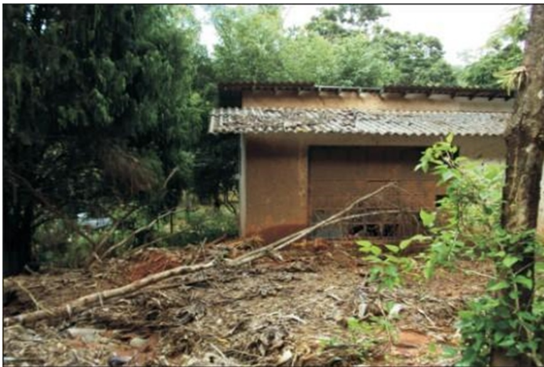
Figura 09: Fotografia de localidade em Vila Nova, após o incidente de 2011 (Fonte: CPRM)
