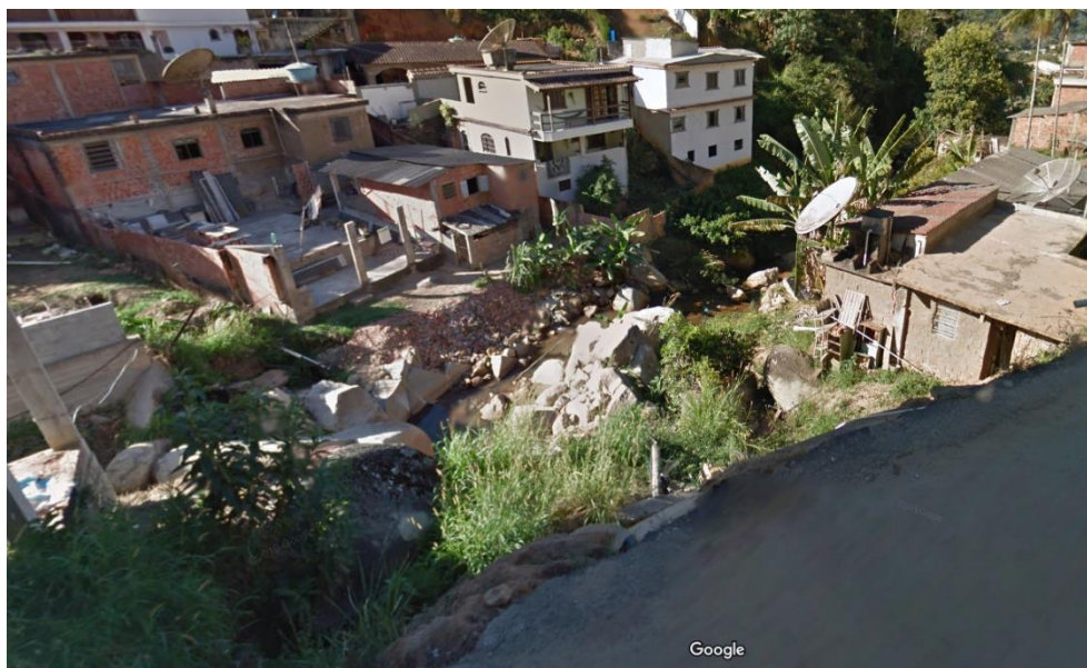
Figura 7 – Servidão Antônio Maria da Conceição e o Córrego a jusante (imagem retirada do Google de agosto de 2011)
