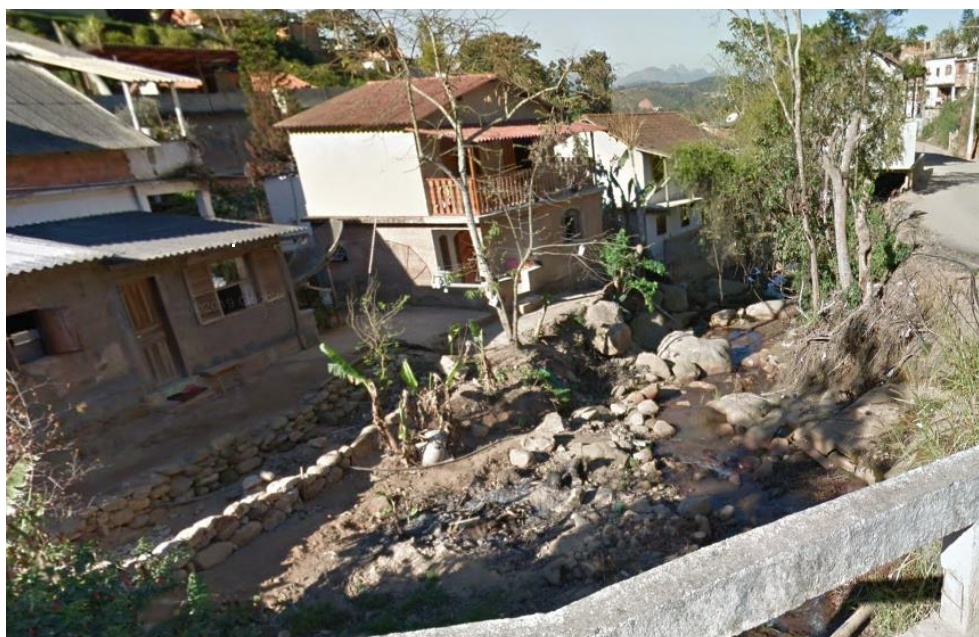
Figura 6 – Servidão Antônio Maria da Conceição e o Córrego a jusante (imagem retirada do Google de agosto de 2011)
