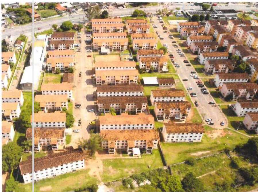
Foto 1 - Conjunto Habitacional Trento – (Fonte: SEINFRA/SUBHAB)
