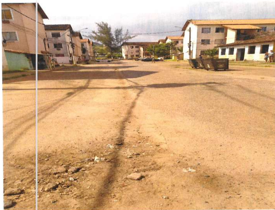
Foto 2: Entrada de acesso aos blocos do condomínio e depósito de lixo. (Fonte: SEINFRA/SUBHAB)
