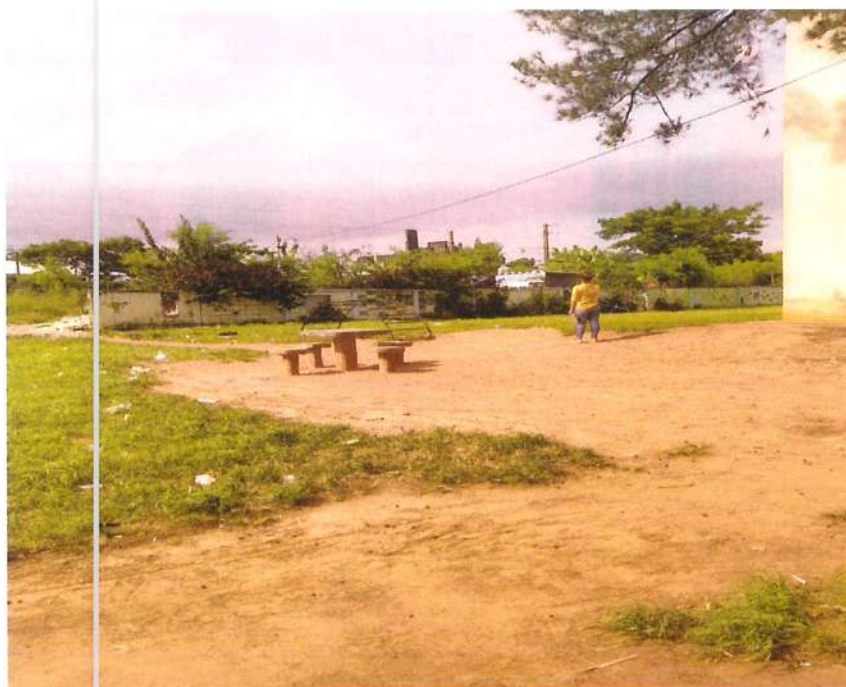
Foto 9: Área dos fundos do terreno com muros quebrados, moradores usam como passagem para uso dos trens. (Fonte: SEINFRA/SUBHAB)
