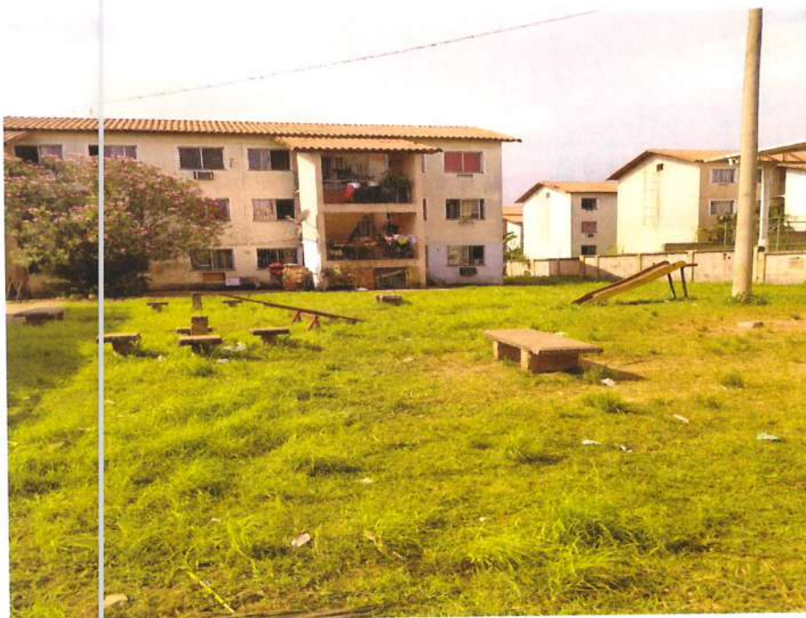
Foto 7: Área de lazer em péssimo estado de conservação. (Fonte: SEINFRA/SUBHAB)
