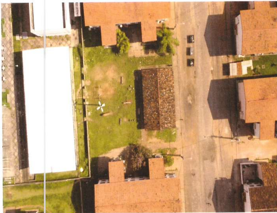
Foto 12: Telhados parcialmente quebrado, gerando infiltrações nos apartamentos do 3º andar. (Fonte: SEINFRA/SUBHAB)
