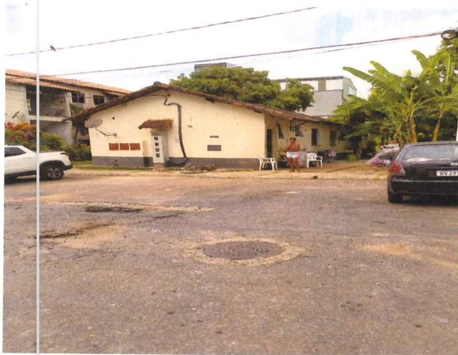
Foto 4: Apartamentos PNE. (Fonte: SEINFRA/SUBHAB)
