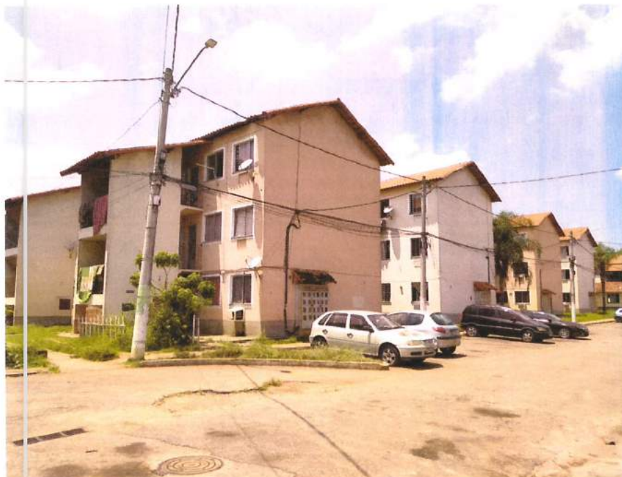
Foto 8: Área de acesso aos blocos do conjunto. (Fonte: SEINFRA/SUBHAB)
