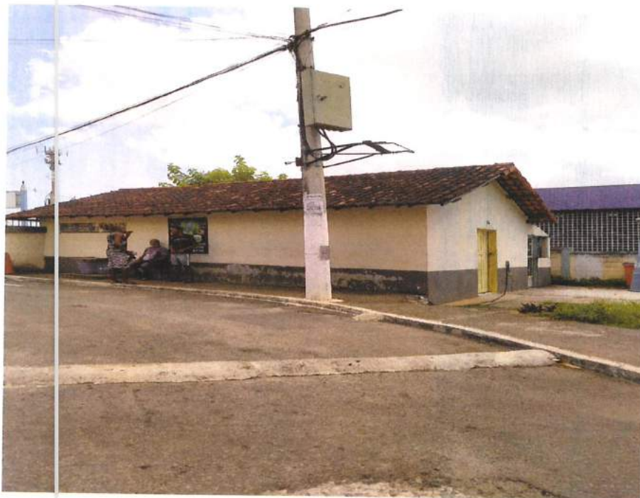
Foto 2: Entrada lateral de acesso aos blocos do condomínio e depósito de lixo. (Fonte: SEINFRA/SUBHAB)
