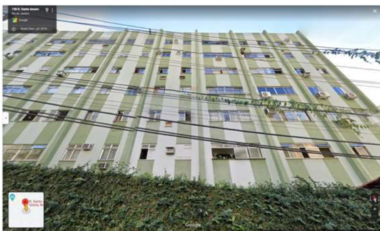
Figura 02: Condomínio Santo Amaro (Fonte: Google Earth)
