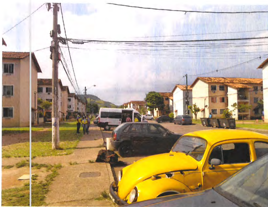
Foto 2: Entrada de acesso aos blocos do condomínio. (Fonte: SEINFRA/SUBHAB)
