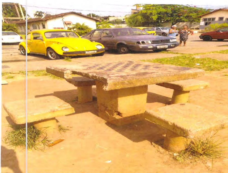
Foto 13: Mesas e bancos de concreto quebrados. (Fonte: SEINFRA/SUBHAB)
