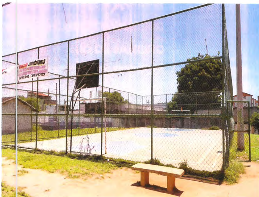
Foto 11: Parte do alambrado da quadra danificada. (Fonte: SEINFRA/SUBHAB)
