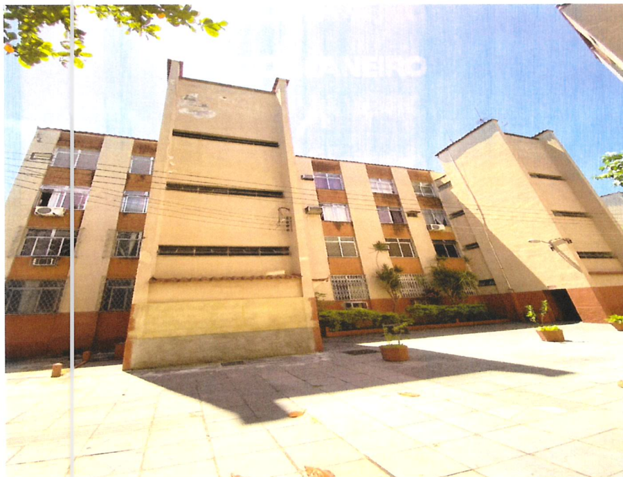
Foto 2: Foto das fachadas dos prédios. (Fonte: SEINFRA/SUBHAB)
