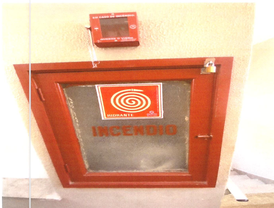
Foto 15: Toda a parte de incêndio do conjunto está atualizada nas Normas do Corpo de Bombeiro. (Fonte: SEINFRA/SUBHAB)
