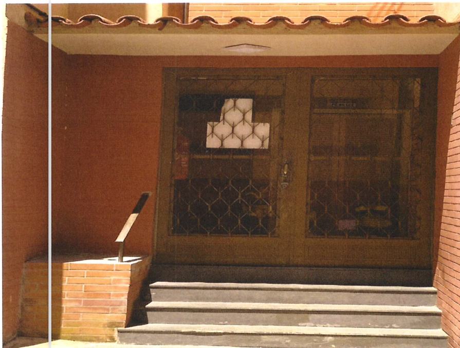
Foto 10: Área de acesso a entrada de um prédio, todas as entradas seguem esse mesmo padrão (Fonte: SEINFRA/SUBHAB)
