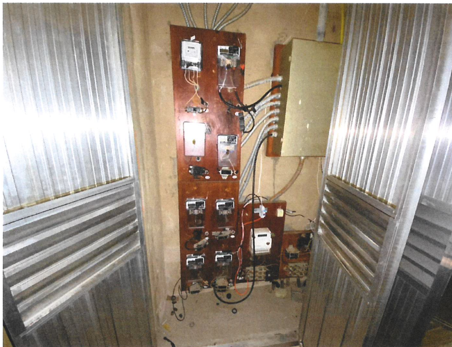
Foto 13: Os Pc's elétricos serão trocados seguindo as normativas da Recon Fonte: SEINFRA/SUBHAB)
