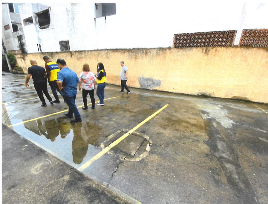
Foto 14: Área externa subutilizada para estacionamento com demanda de área comum de convivência e parque infantil (Fonte: SEINFRA/SUBHAB).
