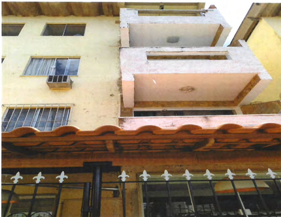
Foto 10: Fachada com estado de conservação razoável, e varanda adicionadas posteriormente a construção (Fonte: SEINFRA/SUBHAB)
