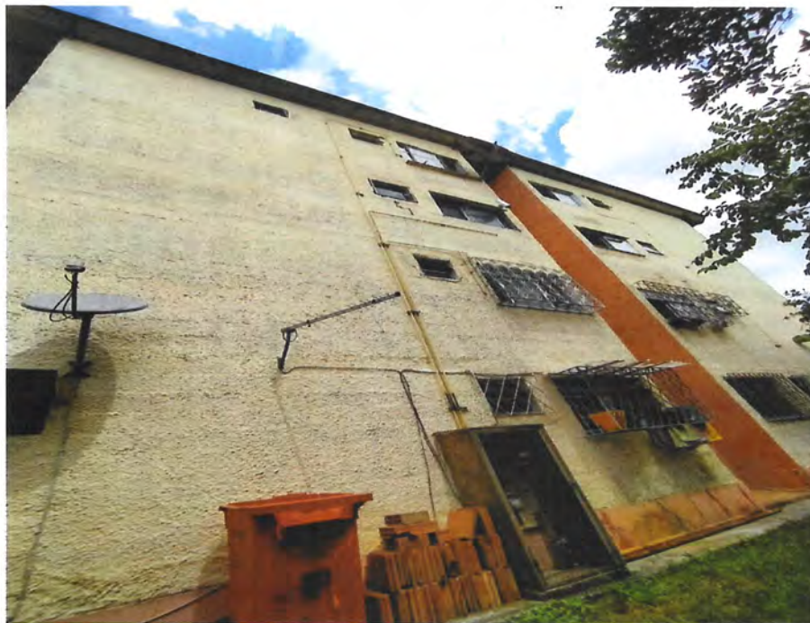
Foto 2: Foto das fachadas de um bloco. (Fonte: SEINFRA/SUBHAB)
