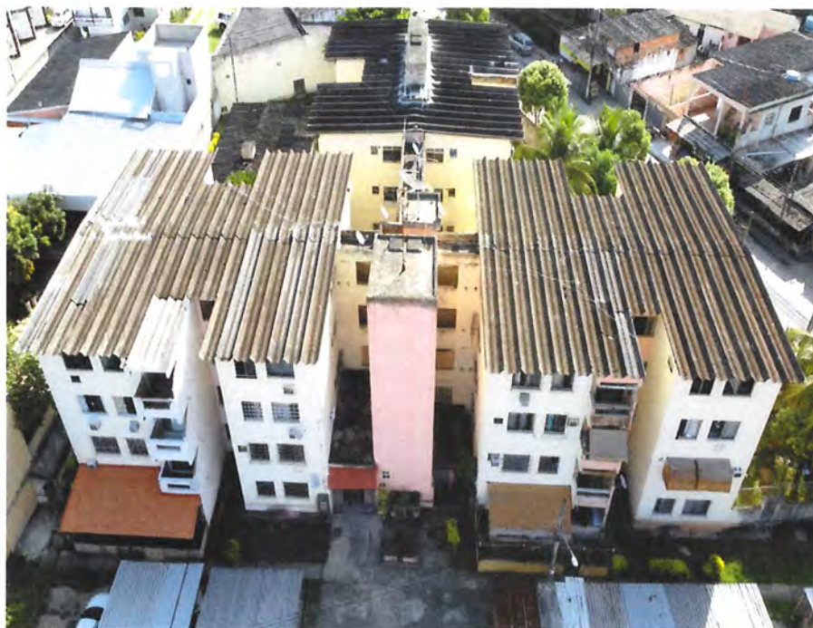
Foto 13: Foto aérea dos telhados e fachada. (Fonte: SEINFRA/SUBHAB)
