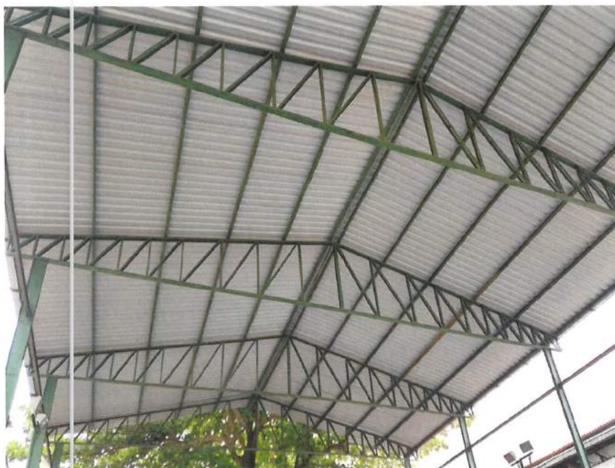
Foto 13: Cobertura da Quadra esportiva (Fonte: SEINFRA/SUBHAB)
