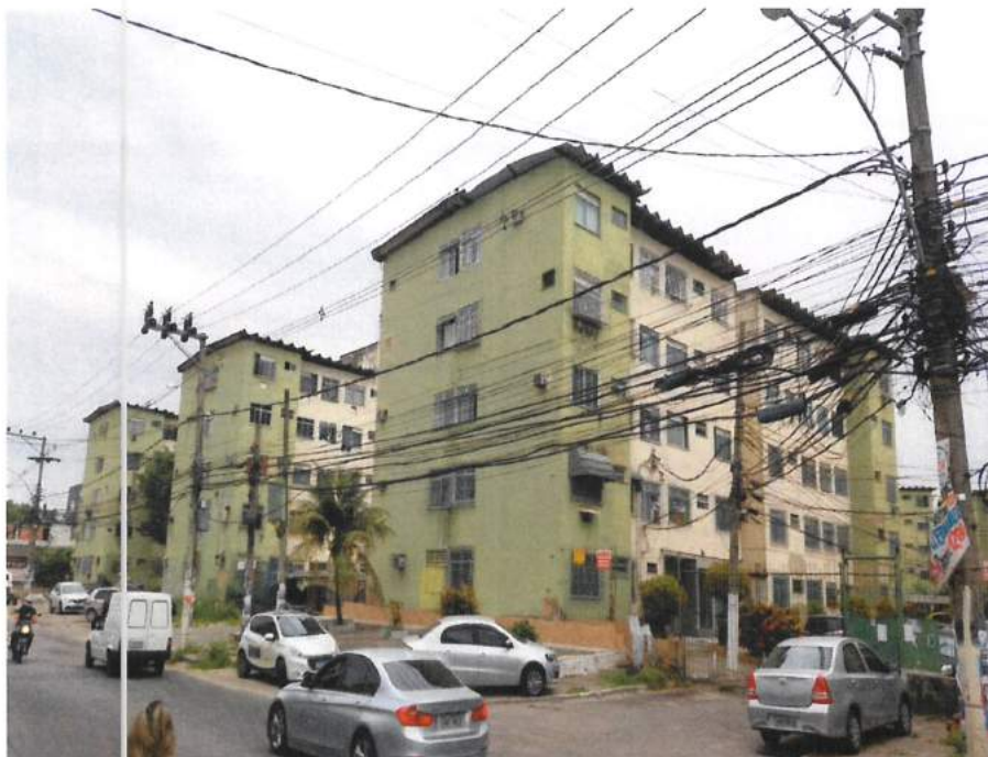
Foto 2: Entrada principal do condomínio (Fonte: SEINFRA/SUBHAB)
