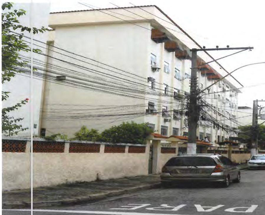
Foto 2: Foto das fachadas de um dos bloco do conjunto. (Fonte: SEINFRA/SUBHAB)
