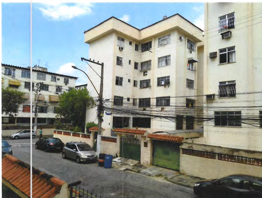
Foto 6: Calçadas externas do conjunto quebradas e sem acessibilidade para pedestres. (Fonte: SEINFRA/SUBHAB)
