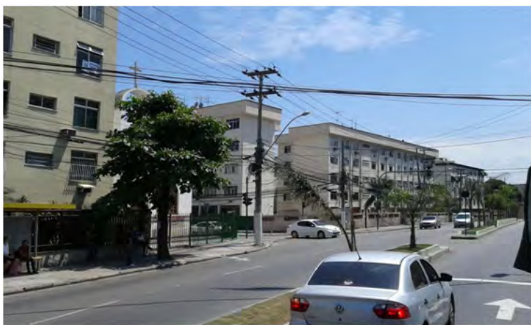
Figura 01: Vista externa do conjunto. (Fonte: SEINFRA)
