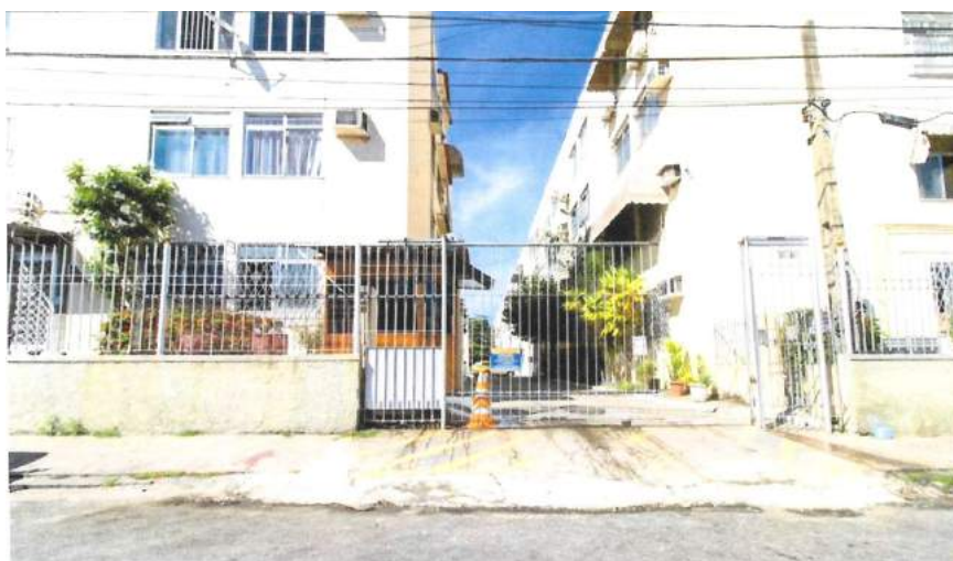
Figura 04: Conjunto Residencial Vicente de Carvalho (Fonte: SEINFRA)
