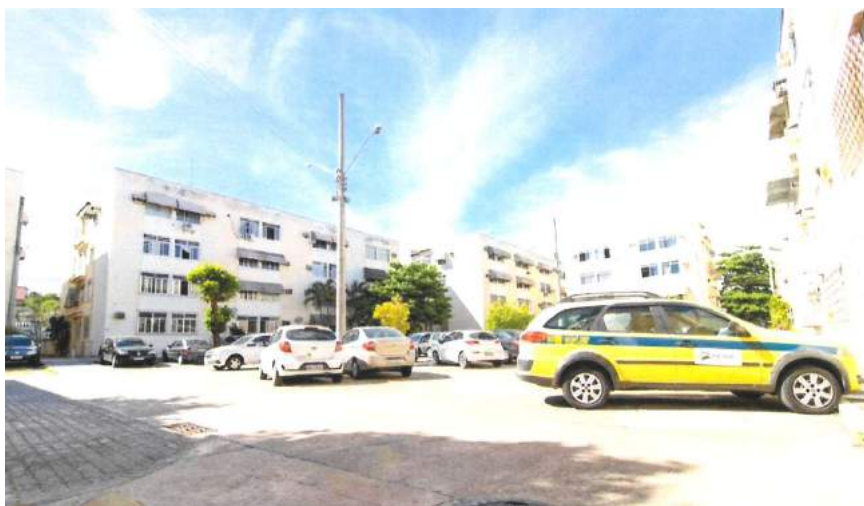
Figura 03: Conjunto Residencial Vicente de Carvalho (Fonte: SEINFRA)
