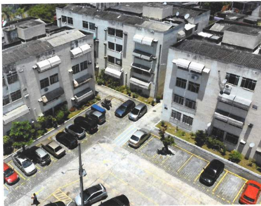
Foto 2: Vista geral do Conjunto Residencial Vicente de Carvalho (Fonte: SEINFRA/SUBHAB)
