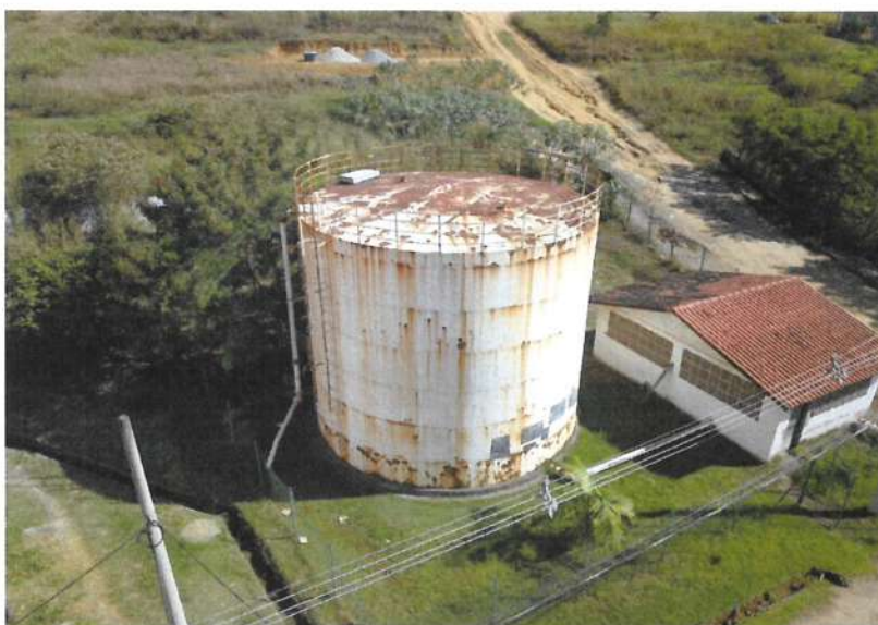
Foto 8 – Reservatório de água e casa de bombas – (Fonte: SUBHAB julho/2021)
