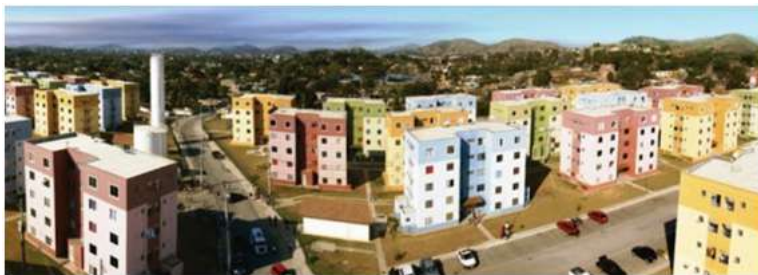
Figura 05: Imagem da inauguração do Conjunto Habitacional Parque Valdariosa, no município de Queimados.
