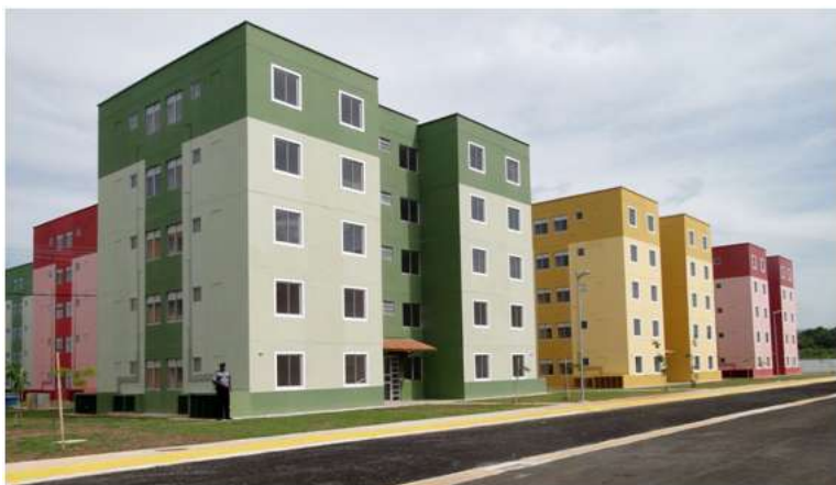
Figura 02: Imagem da inauguração do Conjunto Habitacional Parque Valdariosa, no município de Queimados.
