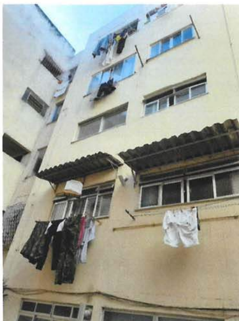
Foto 9: Fachada interna (prisma) (Fonte: SEINFRA/SUBHAB - julho/2021)
