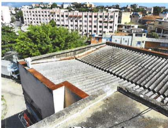
Foto 5: Vista parcial da cobertura de um dos prédios (Fonte: SEINFRA/SUBHAB - julho/2021)
