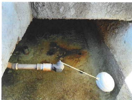
Foto 6: Vista interna de uma caixa d'água (Fonte: SEINFRA/SUBHAB - julho/2021)
