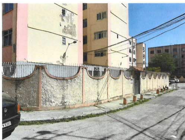
Foto 11: Vista parcial de muros ao redor dos prédios / Conjunto habitacional Oswaldo cruz (Fonte: SEINFRA/SUBHAB - julho/2021)
