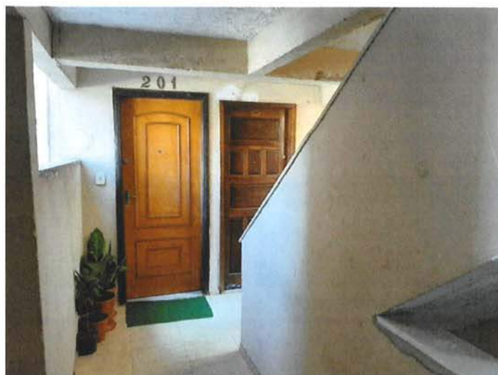
Foto 7: Vista parcial da circulação interna (escada) (Fonte: SEINFRA/SUBHAB - julho/2021)
