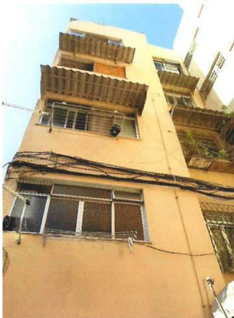
Foto 8: Fachada interna (prisma) (Fonte: SEINFRA/SUBHAB - julho/2021)
