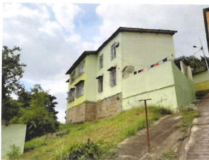
Foto 9: Construção de terraço (Fonte: SEINFRA/SUBHAB - julho/2021)
