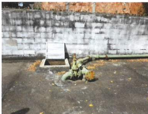
Foto 13: Tubulação de entrada de água ao Reservatório. Solicitaram a substituição, mas não foi detectado nenhum vazamento. (Fonte: SEINFRA/SUBHAB - julho/2021)
