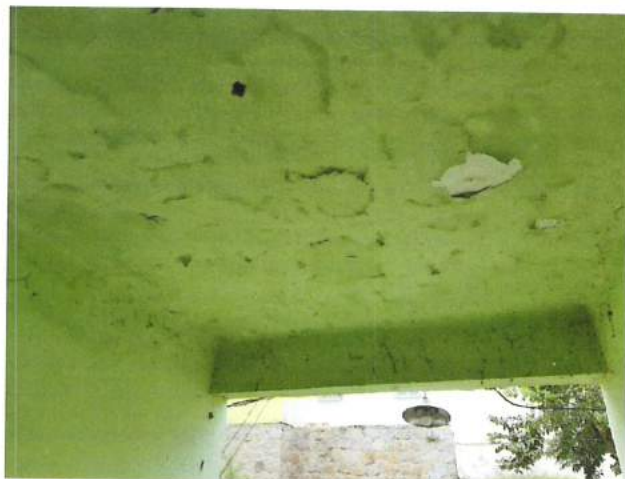
Foto 7: Vista parcial do teto da circulação interna (escada) (Fonte: SEINFRA/SUBHAB - julho/2021)
