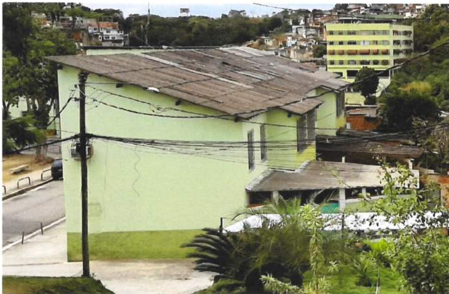
Foto 5: Vista parcial da cobertura de um dos prédios (Fonte: SEINFRA/SUBHAB - julho/2021)
