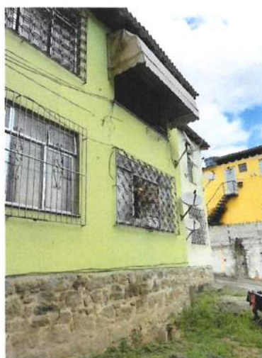
Foto 12: Colocação de ar condicionado, antenas, grades e toldos (Fonte: SEINFRA/SUBHAB - julho/2021)
