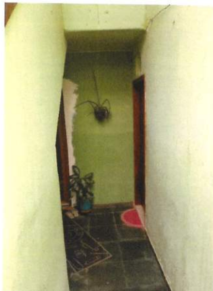
Foto 8: Vista parcial da circulação interna (Fonte: SEINFRA/SUBHAB - julho/2021)
