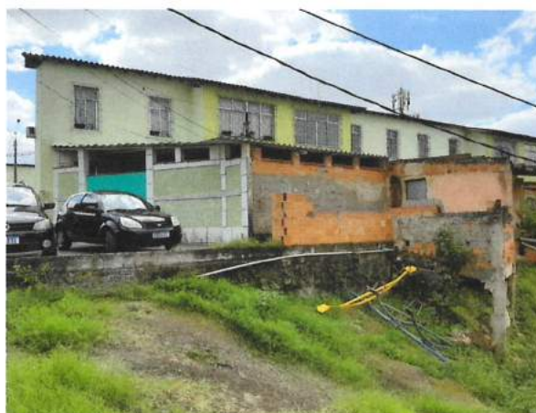
Foto 11: Construção de garagens e pátios cobertos (Fonte: SEINFRA/SUBHAB - julho/2021)
