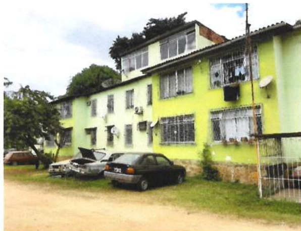
Foto 10: Construção de mais um pavimento (Fonte: SEINFRA/SUBHAB - julho/2021)
