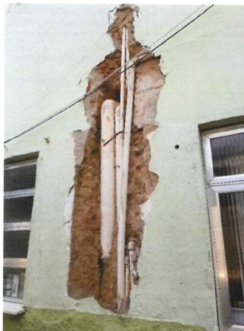
Foto 2: Troca de Tubulação devido a vazamentos (Fonte: SEINFRA/SUBHAB - julho/2021)
