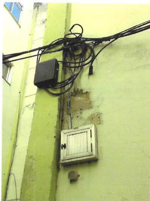
Foto 4 – Fixação de fiações e caixas de passagens na fachada – Fonte: SUBHAB julho/2021)
