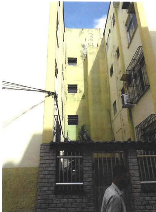
Foto 3 – Colocação de aparelhos de ar condicionado, grades, guarda-corpo e fiações.
