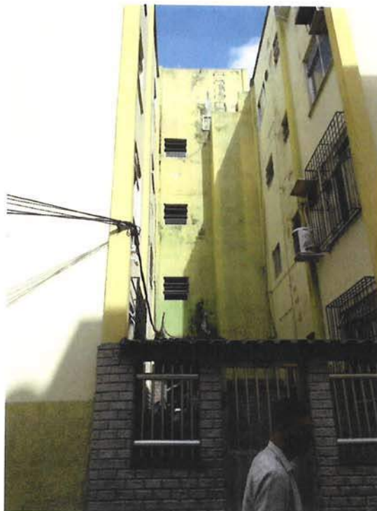
Foto 3 – Colocação de aparelhos de ar condicionado, grades, guarda-corpo e fiações. (Fonte: SUBHAB julho/2021)
