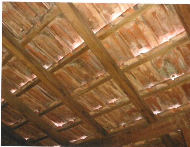
Foto 5: Vista parcial interna do telhado de um dos prédios (Fonte: SEINFRA/SUBHAB - julho/2021)
