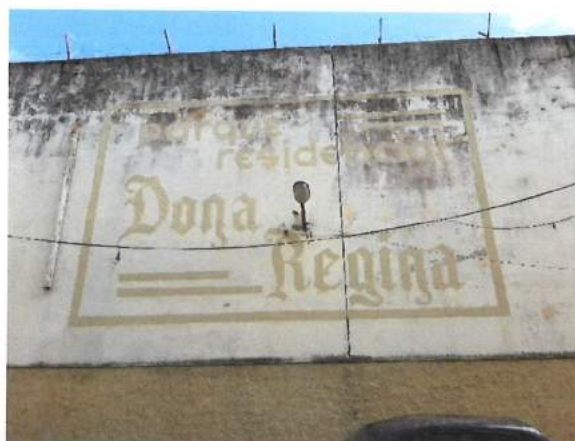
Foto 4: Vista parcial do muro dos fundos do Conjunto Habitacional (Fonte: SEINFRA/SUBHAB - julho/2021)
