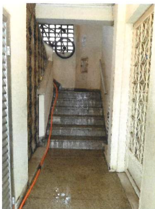
Foto 11: Vista parcial da circulação interna (escada) (Fonte: SEINFRA/SUBHAB - julho/2021)
