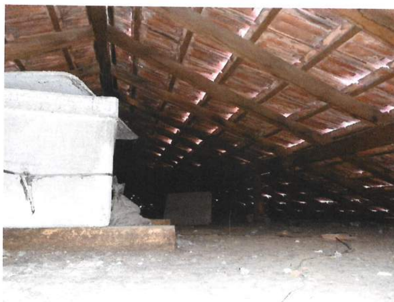
Foto 6: Vista parcial interna do telhado de um dos prédios (Fonte: SEINFRA/SUBHAB - julho/2021)
