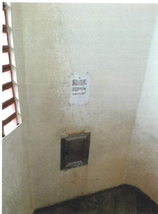
Foto 10: Vista parcial da circulação interna (escada) (Fonte: SEINFRA/SUBHAB - julho/2021)
