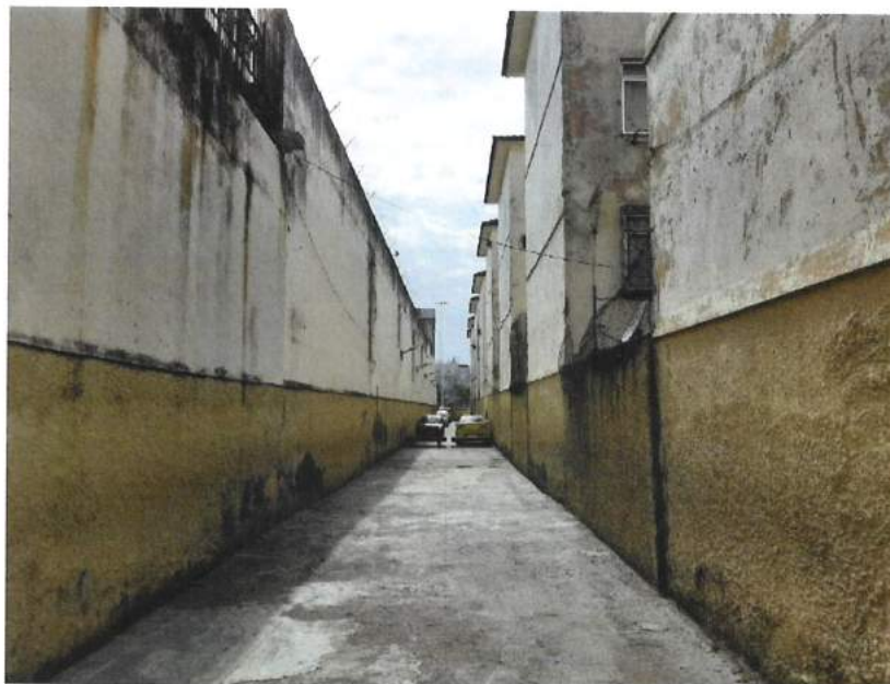
Foto 14: Vista do pátio descoberto (Fundos) (Fonte: SEINFRA/SUBHAB - julho/2021)
