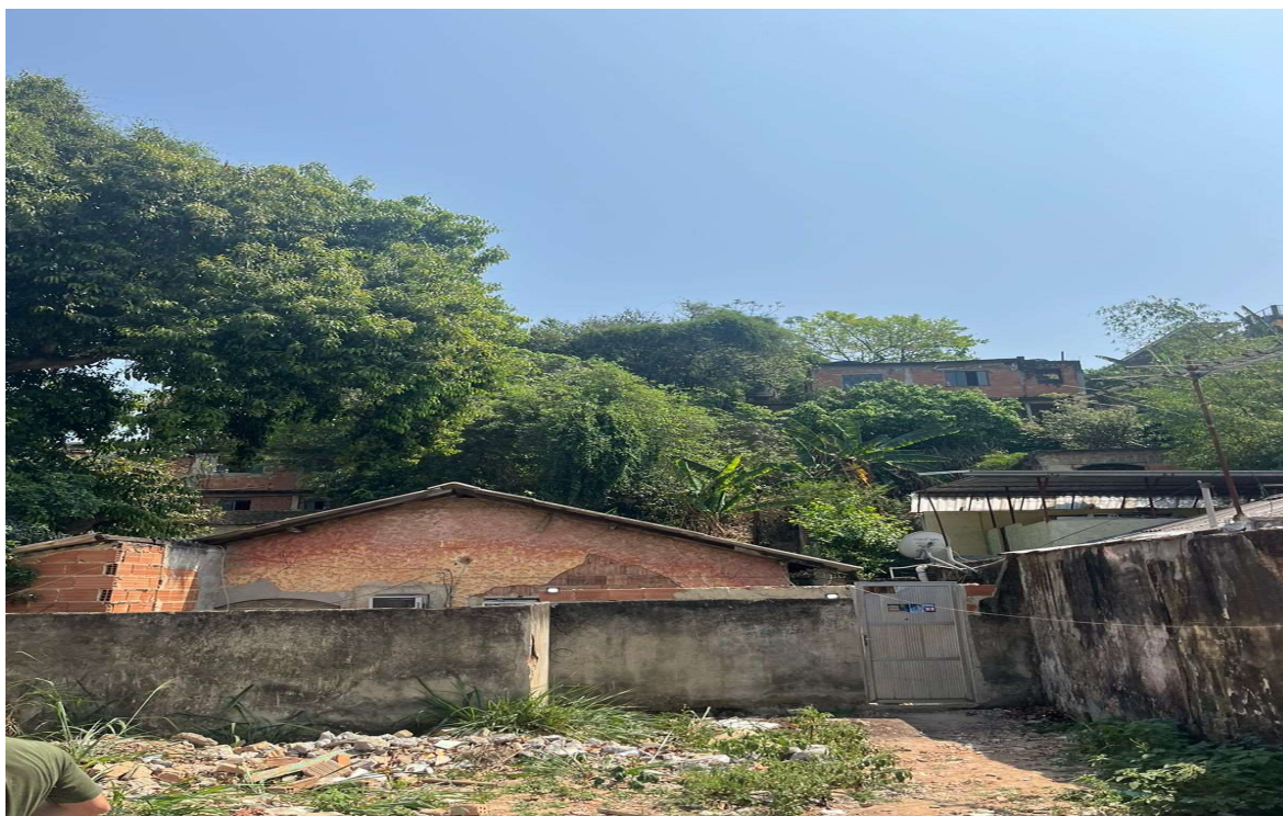
ESPECIFICAÇÃO DO SERVIÇO; CONTENÇÃO SOLO GRAMPEADO COM CONCRETO PROJETADO
