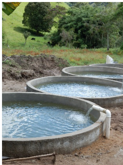
Figura 5. Tanques de alvenaria circular. Fonte: Arquivo FIPERJ
