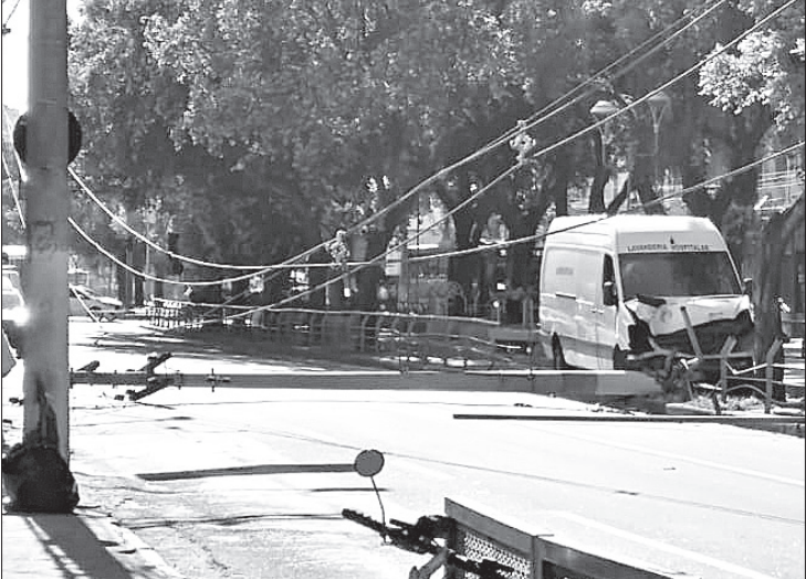
O poste caído acabou ocasionando o bloqueio das pistas sentido Niterói
