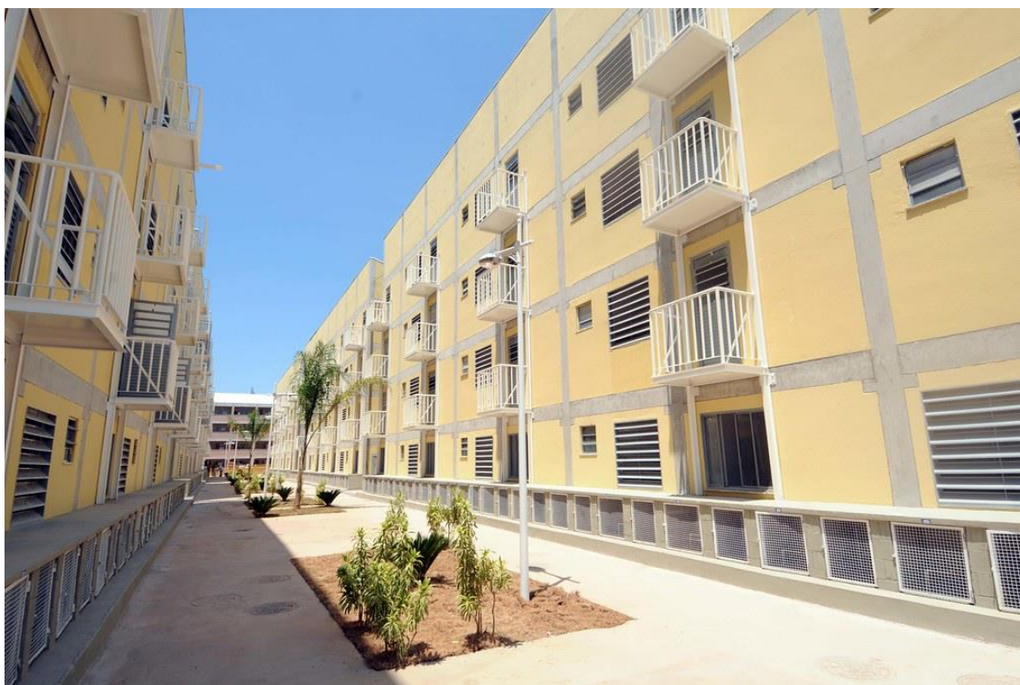
Figura 1: Conjunto Habitacional Condomínio DSUP - Maguinhos
