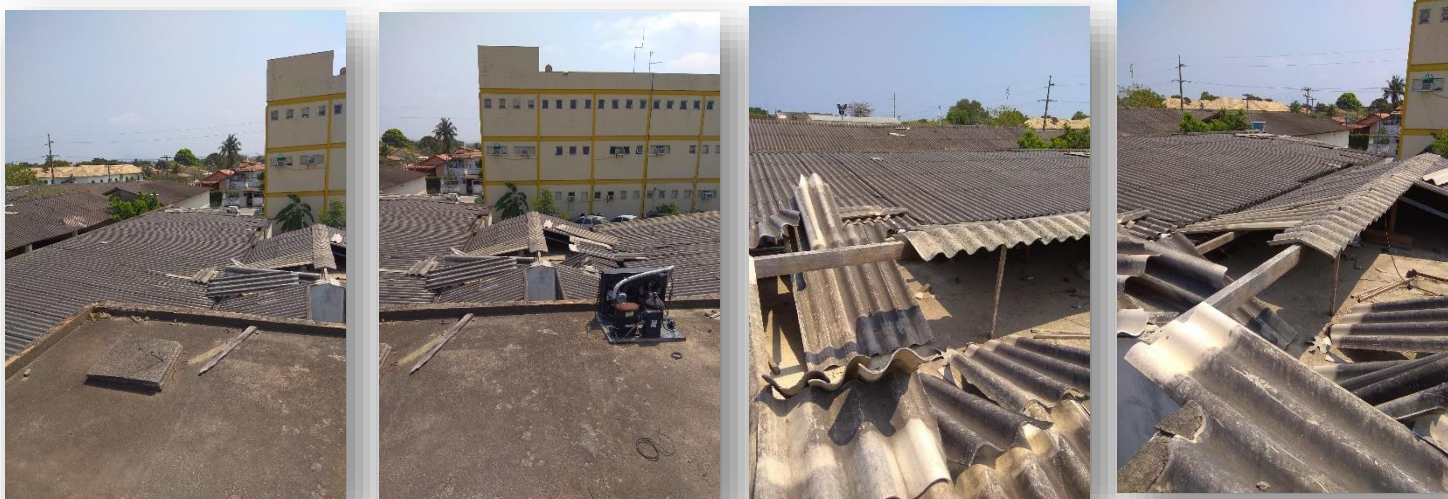
Telhas quebradas na parte que abriga a necrópsia e sala de digitação.
