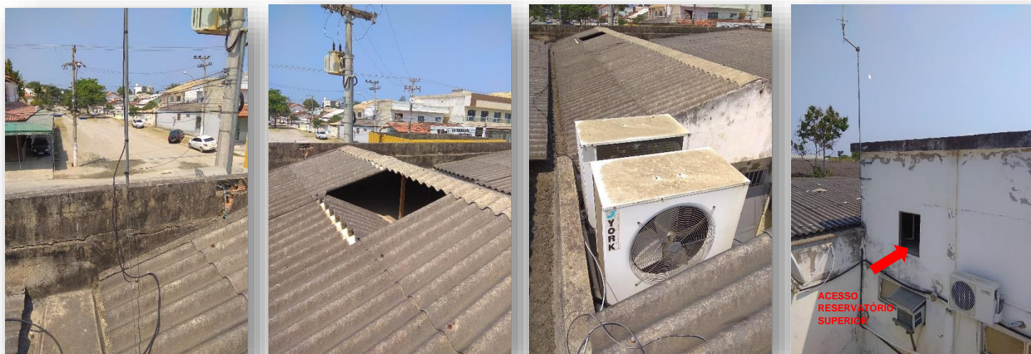
Telhas quebradas na parte que abriga a necrópsia e sala de digitação.
