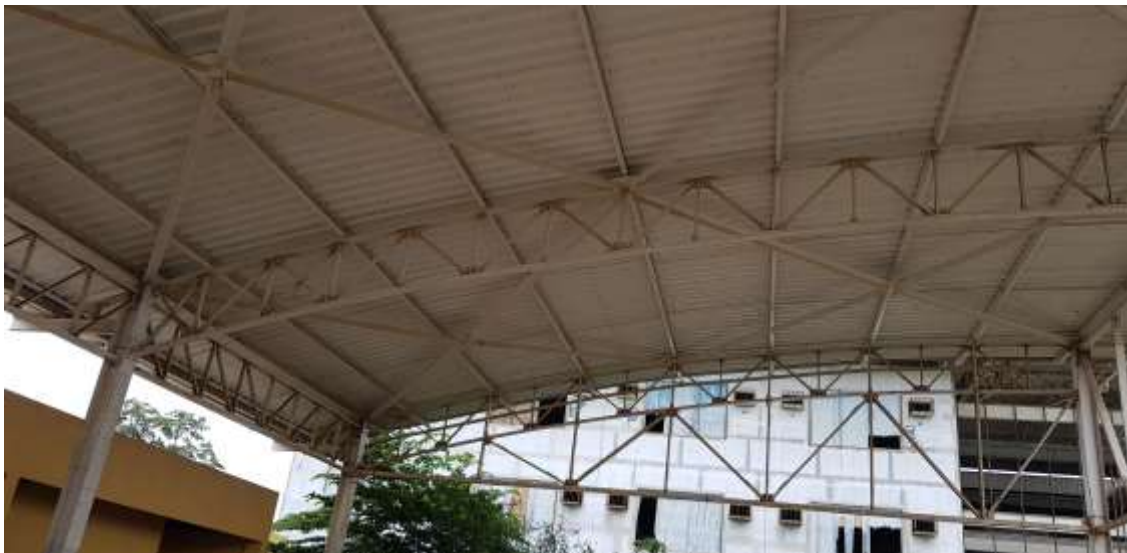
Vista da estrutura metálica e cobertura da quadra
