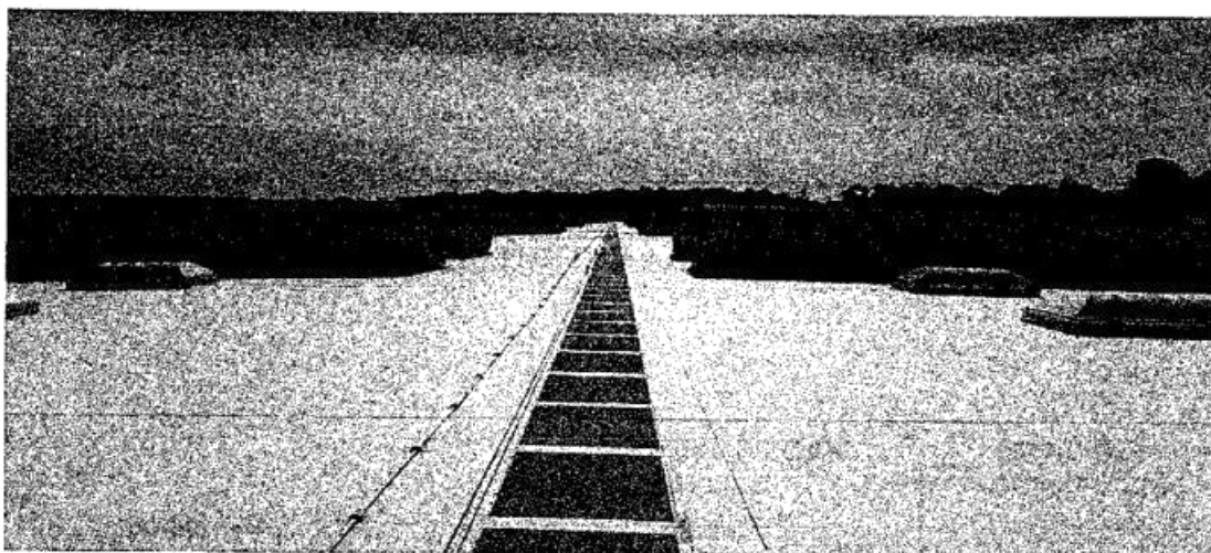
COBERTURA COM ULTRAPLY TPO + PASSARELA + SPDA + LANTERNINS
