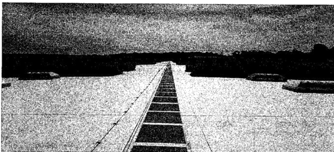
COBERTURA COM ULTRAPLY TPO + PASSARELA + SPDA + LANTERNINS
