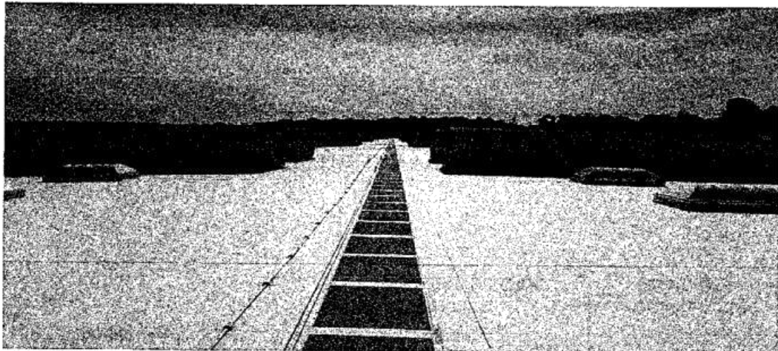
COBERTURA COM ULTRAPLY TPO + PASSARELA + SPDA + LANTERNINS
