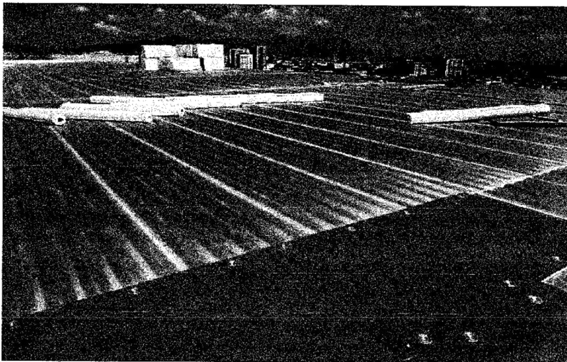
APÓS AS TELHAS FIXADAS NA ESTRUTURA É FIXADO O ISO + TPO
