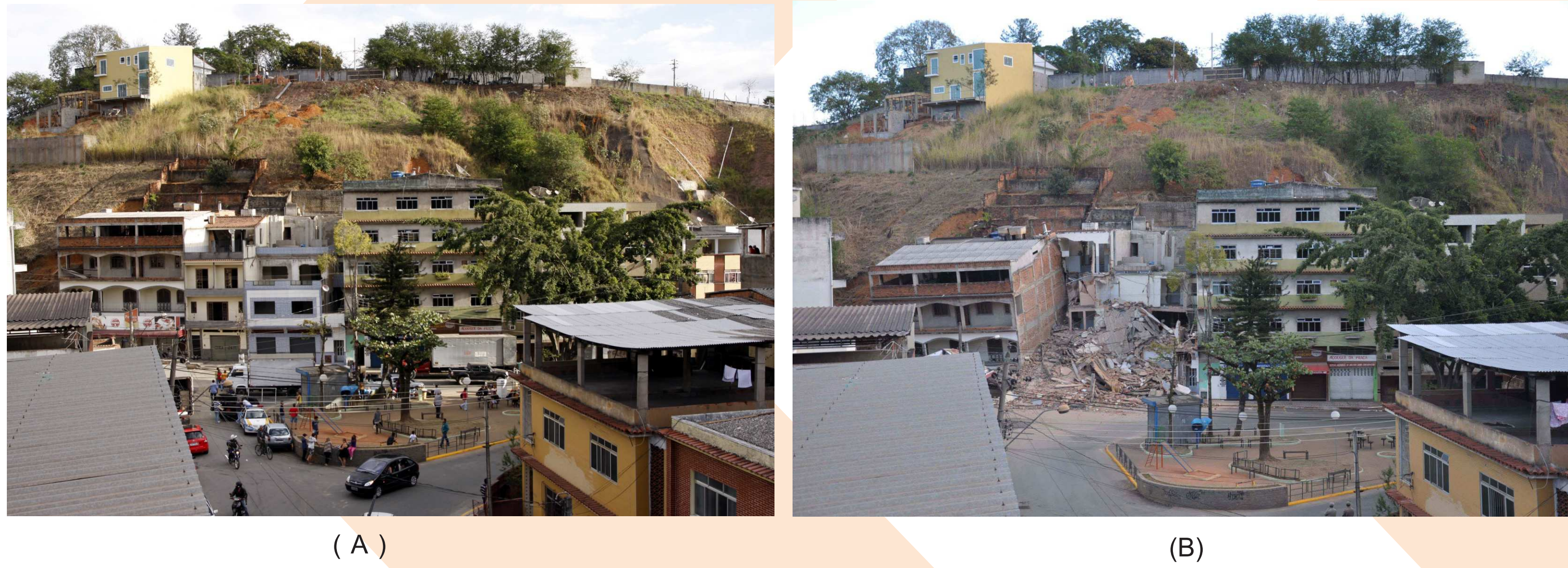
Figura 1. Situação da encosta antes e depois do escorregamento.
