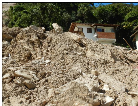
Figura 5. Residência parcialmente destruída pelos movimentos gravitacionais de massa.
