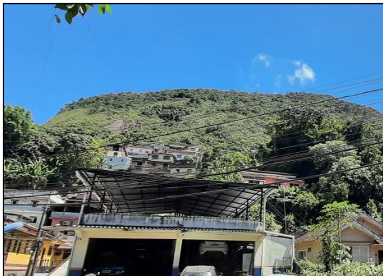
Figura 12. Construções situadas na encosta.
