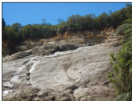
Figura 9. Visão do topo da encosta.
