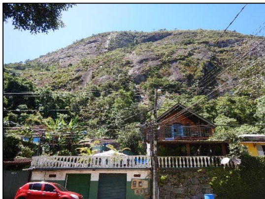
Figura 16. Construções situadas na base da encosta.
