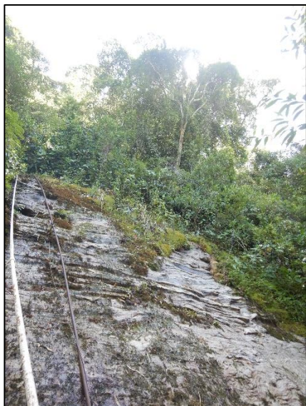
Figura 14. Solo pouco espesso em maciço rochoso.
