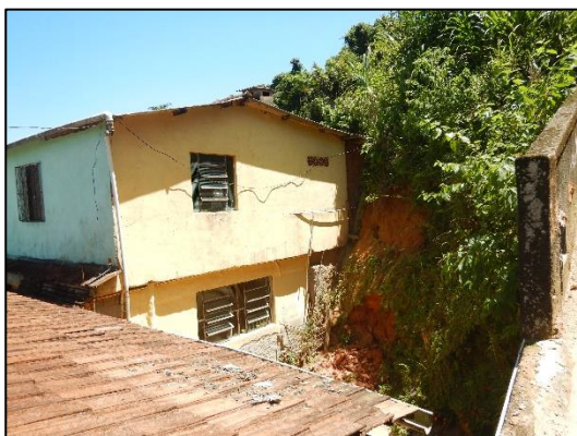
Figura 10. Residência junta a talude de corte.
