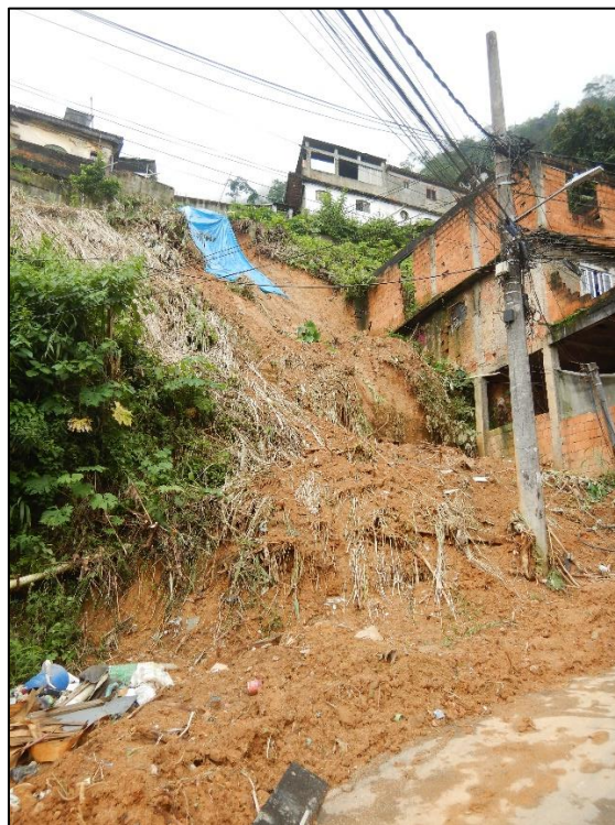
Figura 3. Cicatriz de deslizamento planar.
