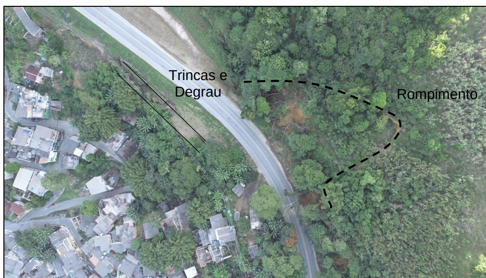
Figura 22: Fotointerpretação de trincas com vários degraus de abatimento.
