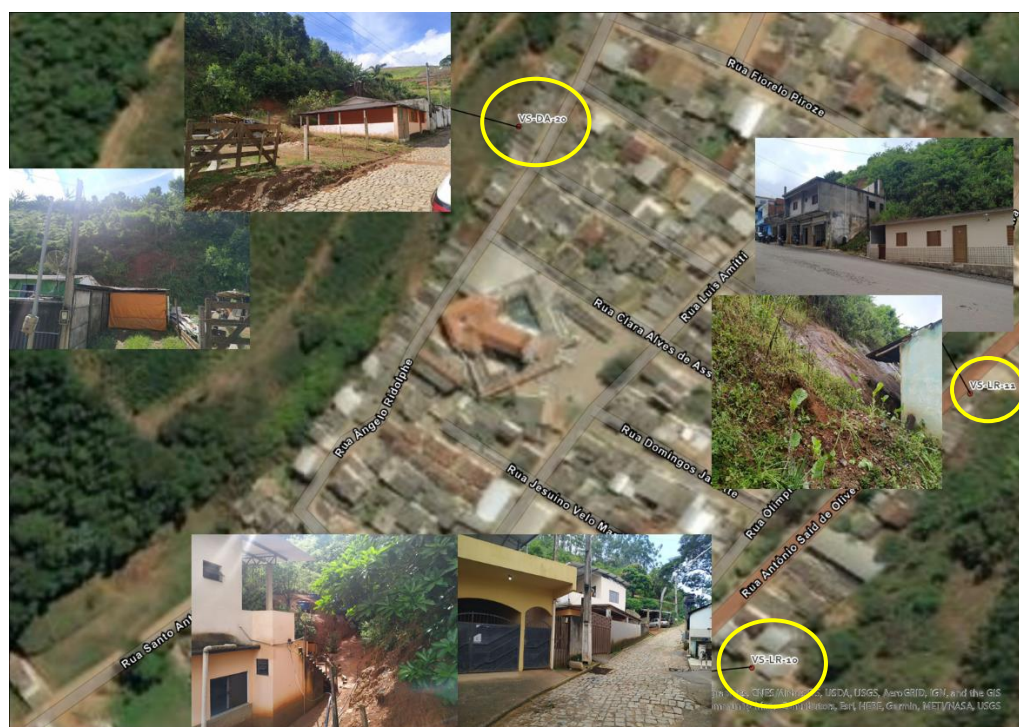
Figura 7: Setores vistoriados nos bairros Centro, Nossa Senhora Aparecida e Santo Antônio.
