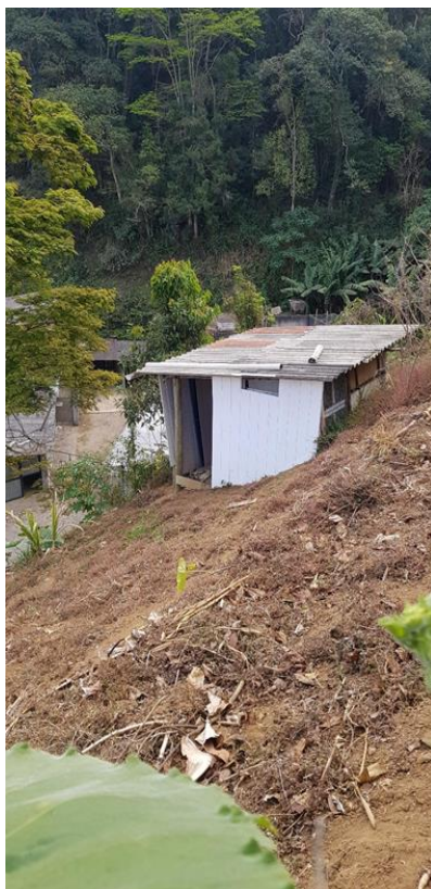
Figura 3: Construção no terreno que serve para armazenar ferramentas.
