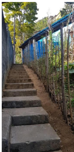
Figura 4: Escada de acesso ao terreno analisado.
