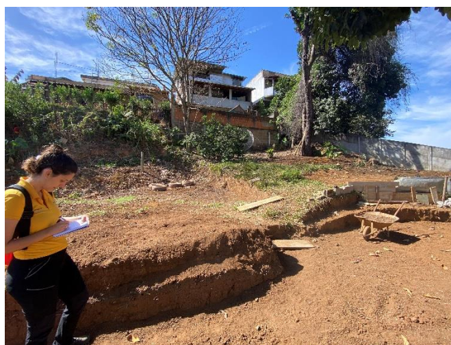
Figura 4 – Cortes contínuos realizados no terreno.
