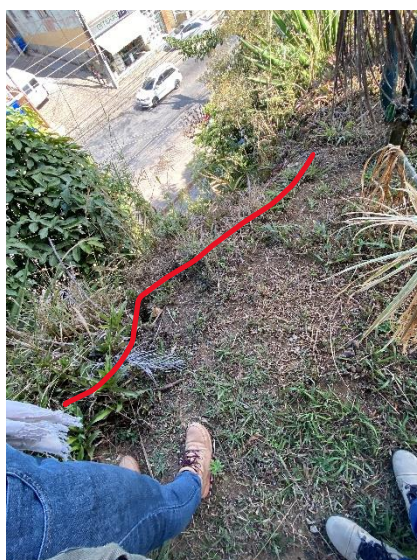
Figura 2– Processo erosivo de pequena dimensão em evolução no jardim frontal da residência.
