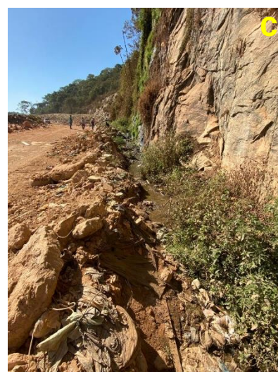
Figura 11: Encosta na porção leste do aterro. A - Encosta rochosa com presença de lascas e blocos em processo de individualização; B - Ponto de exfiltração de água sobre a face da encosta; C - Vala com acúmulo de lixiviado.
