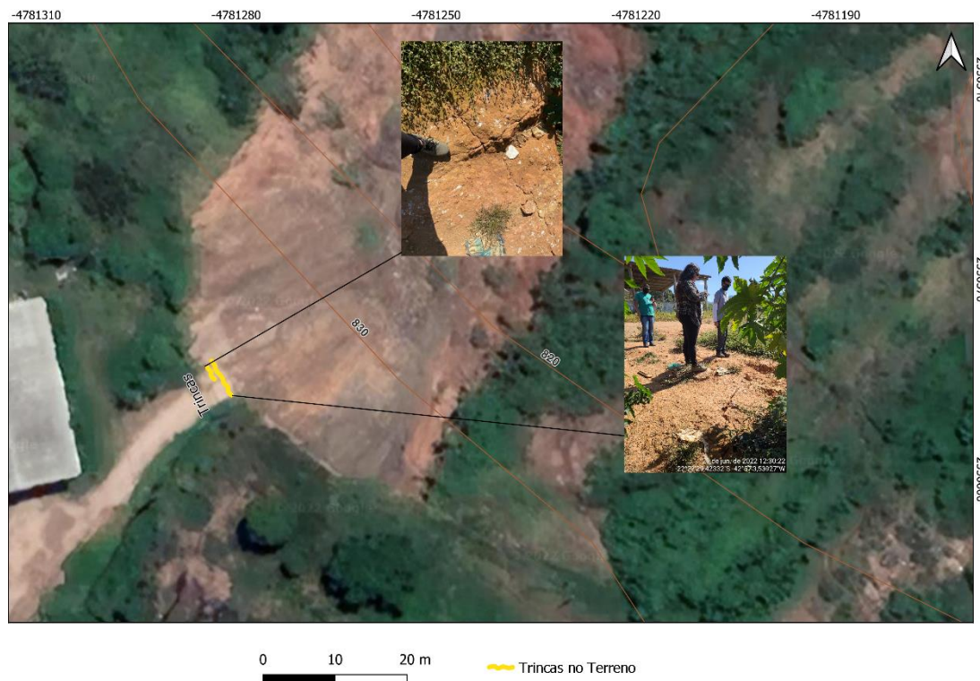
Figura 6 : Mapa de localização das trincas encontradas no terreno.
