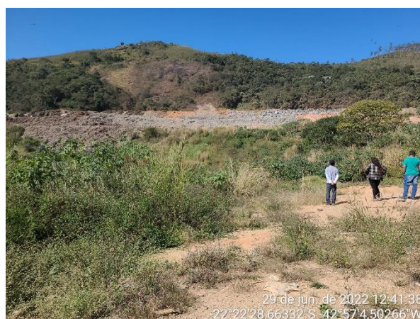
Figura 9: Visada para a porção leste do aterro, onde a operação de disposição de resíduos segue ativa.
