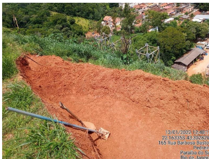
Figuras 6 e 7 – Canaleta de drenagem próxima a escarpa rochosa e canos de distribuição de água.
