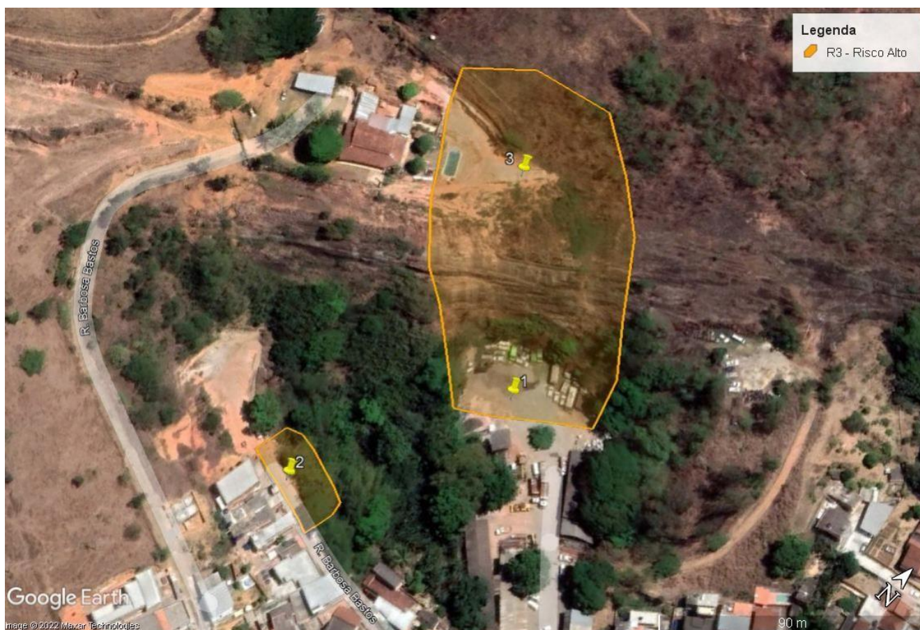
Figura 9 – Polígono de Risco Alto para os três locais – Rua Barbosa Bastos, Bairro Pedreira.
