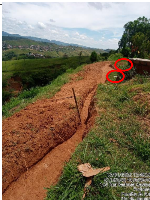
Figuras 6 e 7 – Canaleta de drenagem próxima a escarpa rochosa e canos de distribuição de água.
