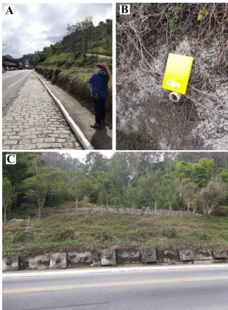
Figura 2: Muro de contenção às margens da RJ 116. A) Muro de cimento com tirantes; B) Dreno; C) Vista frontal das cortinas atirantadas.
