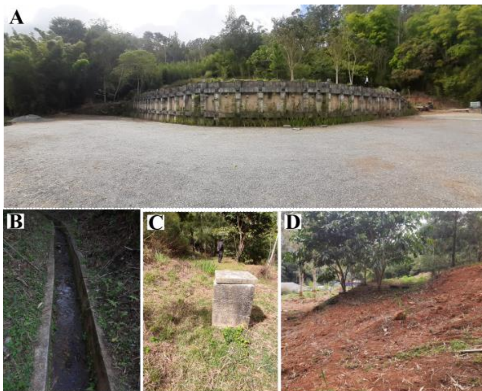
Figura 3: A) Foto panorâmica da contenção com drenos e tirantes, em talude à montante da RJ 116; B) Sistema de captação e direcionamento hidráulico; C) Piezômetros; D) Talude em degraus (retaludamento).
