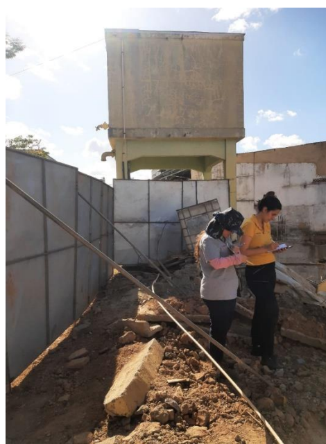
Figura 4: Caixa d'água ameaçada pelo avanço da erosão do terreno situada na calçada da via.
