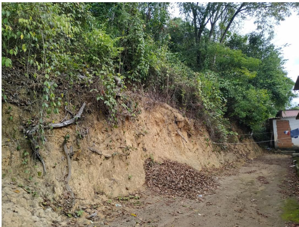
Figura 1: Talude de corte no terreno vistoriado.
