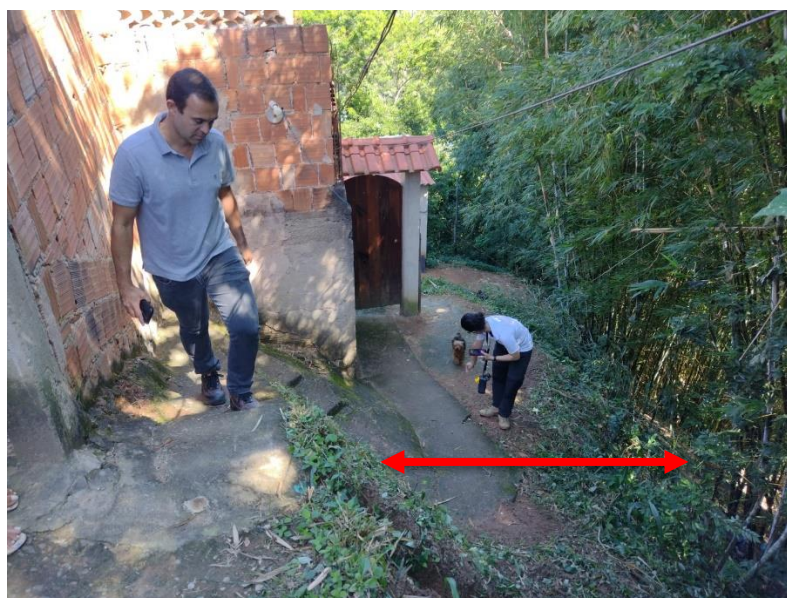
Figura 7 – Distância do topo do talude até as residências.
