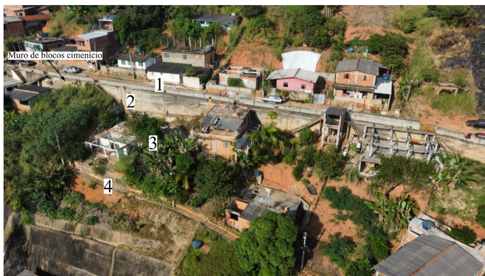
Figura 2: Imagem frontal do muro de contenção com os pontos críticos observado. 1) Via e casas; 2) Muro de bloco cimentício; 3) Casas demolidas a jusante do muro; 4) Calçamento.
