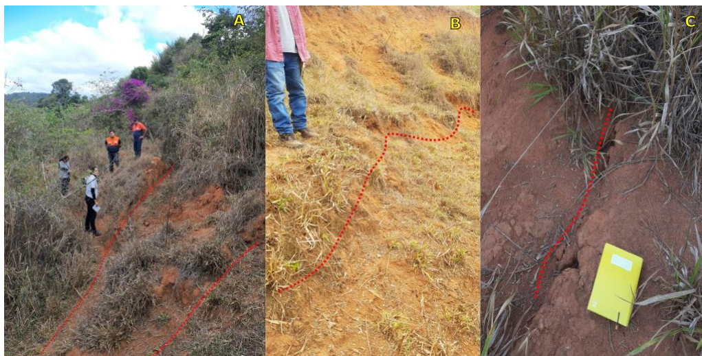
Figura 4: Feições na encosta, respectivamente: “A” e “B” degraus de abatimento na encosta e “C” rachadura no solo e desnível entre os dois patamares.
