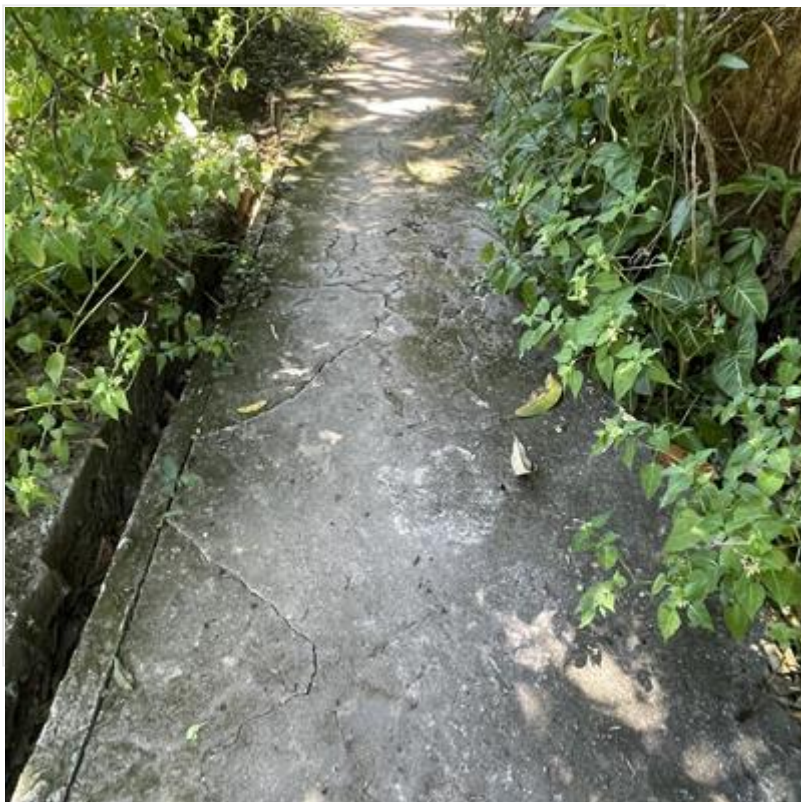
Foto Trincas no terreno
