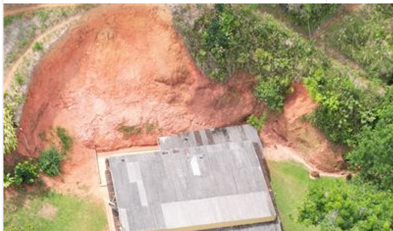
distância talude casa.jpg
