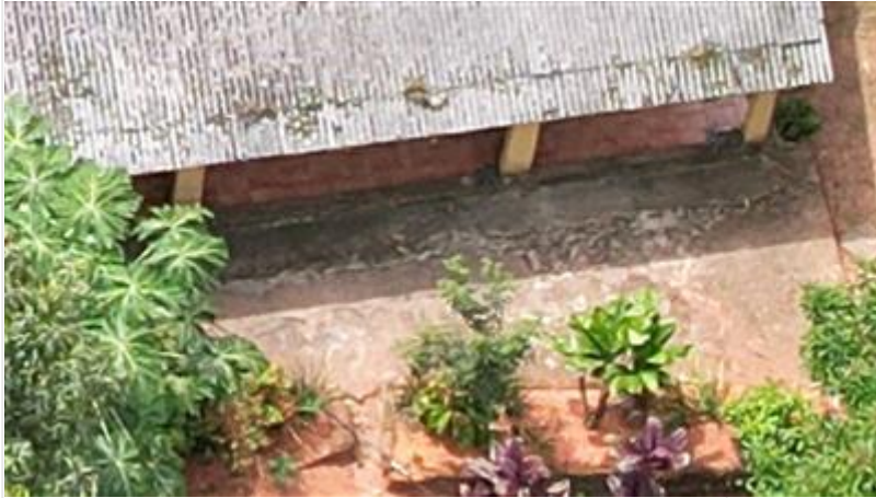
Foto_trinca no terreno.jpg
