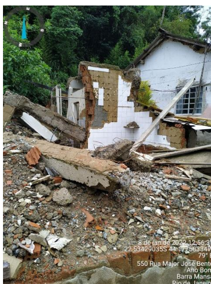
Figura 7, 8 e 9: casa nº 01, 22 e casa demolida respectivamente.
