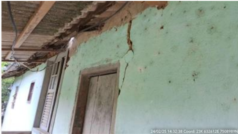
Foto_Trincas_em_moradias-20250224-173237.jpg
