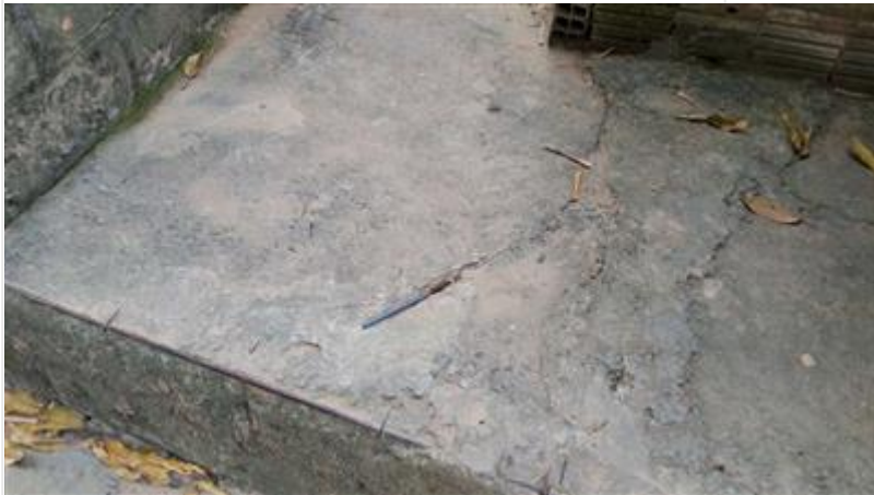
Foto_Trincas_no_terreno-20250212-183556.jpg
