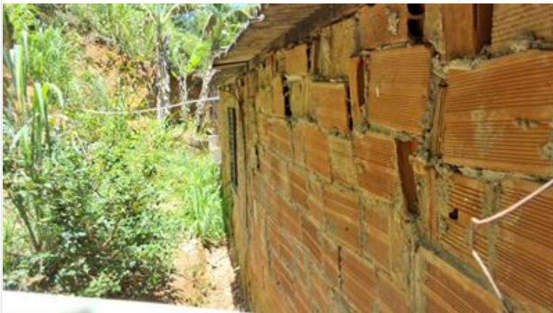
Foto_Muros_paredes_abaulados-20250205-141155.jpg
