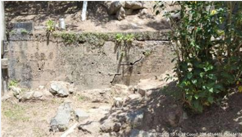
Foto_Trincas_em_muros-20250219-131638.jpg
